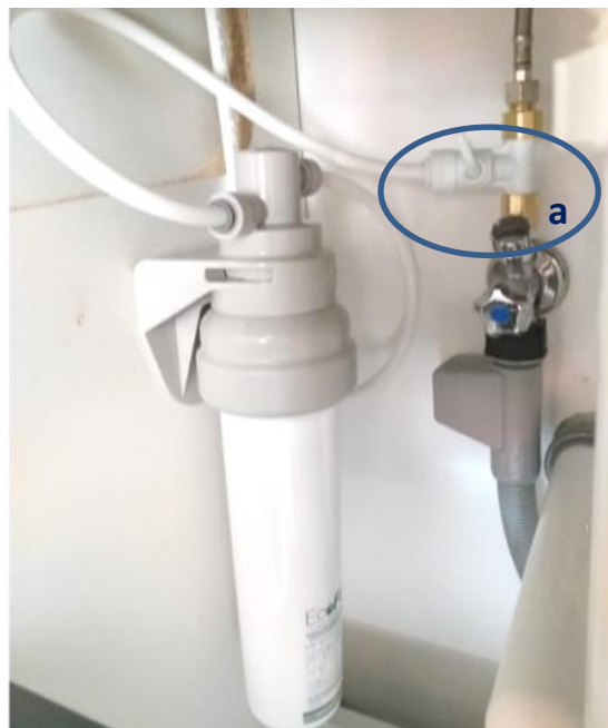
a) JG vízelosztó menetes T- csatlakozás 3/8" hideg víz sarokszelepre
